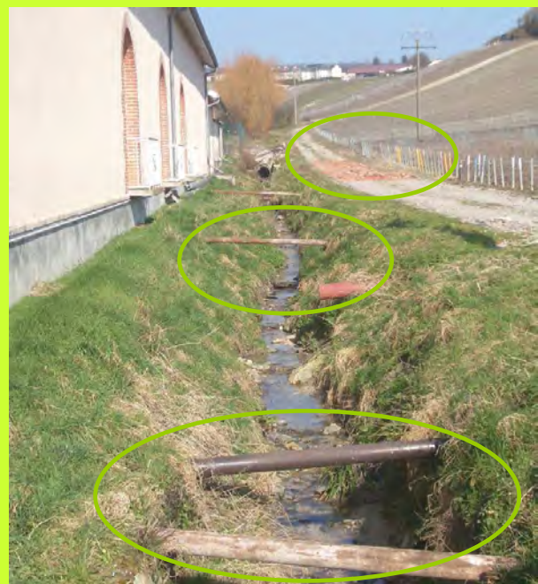
Système de protection d'arrosage contre la gelée non intégré, et apparent dans le fossé d'écoulement des eaux de source de la montagne
