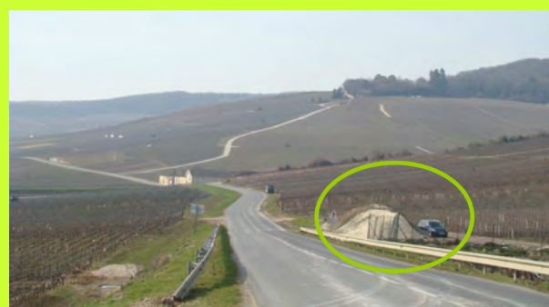
Amoncellement de matériaux et de gravas sous forme de tas le long des fossés et des vignes
