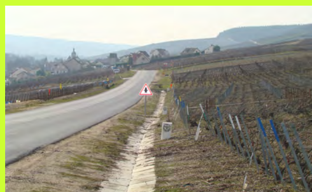
Des aménagements de fossé, à l'image urbaine, pour l'écoulement des eaux, qui sont mal adaptés aux espaces ruraux
