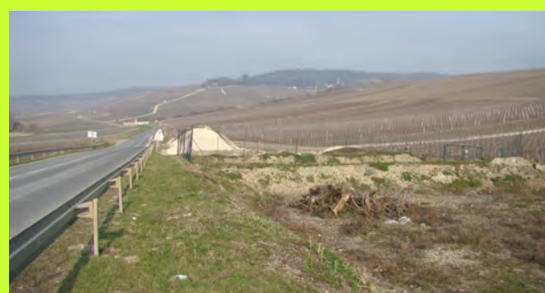
Le bassin hydraulique, formé de talus et encerclé d'un grillage de teinte verte, présente un traitement disgracieux.
