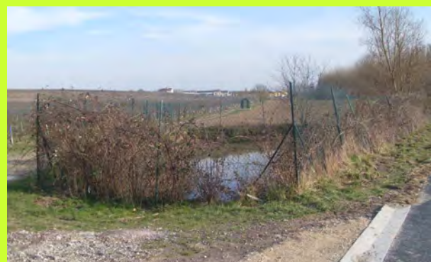
A la croisée d'un chemin de vigne et d'une voie communale, le bassin hydraulique de petite dimension est encerclé d'un grillage et d'arbustes, fortement visibles sur la plaine.
