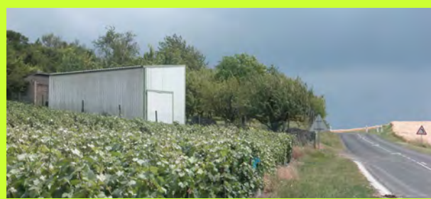
Eviter les matériaux peu qualitatifs, qui appauvrissent la qualité du paysage – hangar au sein de la Montagne de Reims
