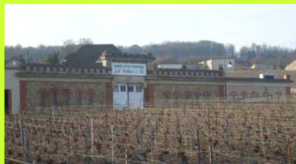
La pépinière et son extension récente de même vocabulaire architecturale, qui allonge l'édifice originel, s'insèrent dans la pente du versant de vignes le long de la D386.
