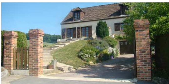
Intégration d'un garage dans la construction avec un aspect massif du volume
