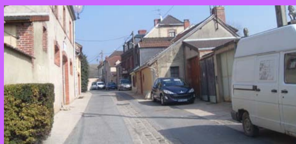
L'aménagement de l'espace public, rue des Buttes, permet de donner une nouvelle cohérence au tissu hétérogène. La forte minéralité du cadre a nécessité l'apport régulier de massifs.
