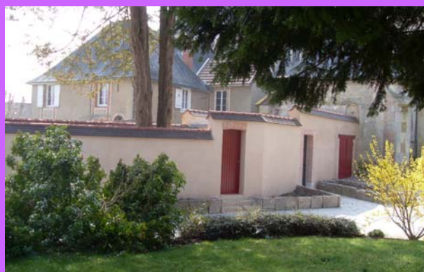
Embellir les édifices patrimoniaux par un traitement végétal soigné, associant différentes essences
