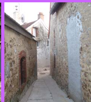
Traitement très minéral et continu entre les murs en pierre et le sol en béton de la ruelle
