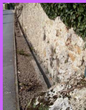
Ecoulement des eaux à travers une rigole creusée, le long des murs de clôture
