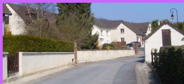
Un traitement sobre des rues dans le tissu diffus : les trottoirs peu larges en béton et en pavés béton de teinte rose sont situés au même niveau que la route.
