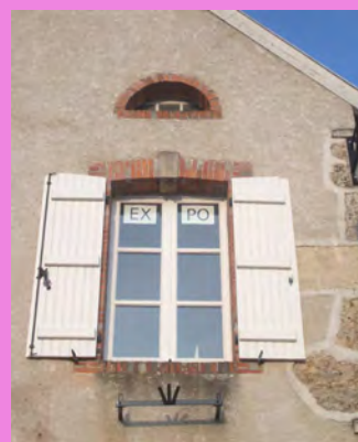
Deux types de percement, soulignés par deux encadrements de briques : fenêtre à un linteau voûté et porte rehaussée d'une imposte, associée à une marquise en verre
