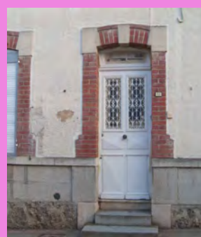
Menuiseries bois peintes de la porte d'entrée avec de fines, ferronneries de même teinte blanche
