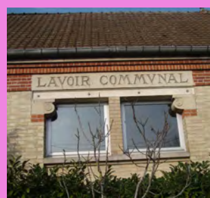
Baie divisée en deux parties par un meneau, revêtu de briques
