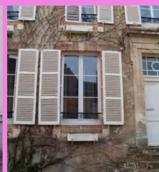
Ouverture à deux vantaux, divisés en 3 parties égales par des petits bois
