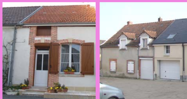
Variété de matériaux et de teintes : L'ardoise et la tuile caractérisent les toits des constructions de Hautvillers.
