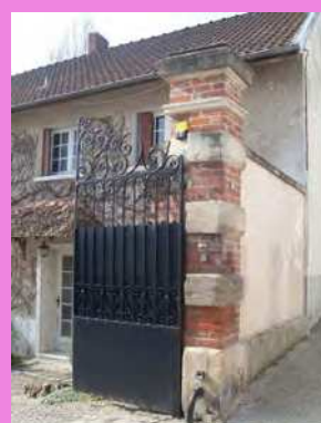
Appareillage de brique et de pierre pour des piliers du portail
