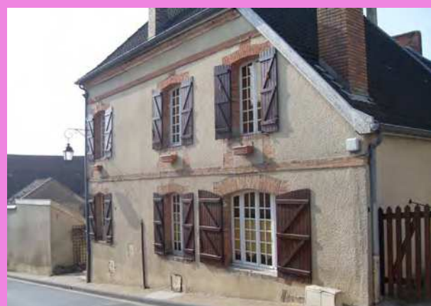
Façade de teinte ocre orangée, caractérisée par des encadrements en brique, associés à des volets bruns foncés
