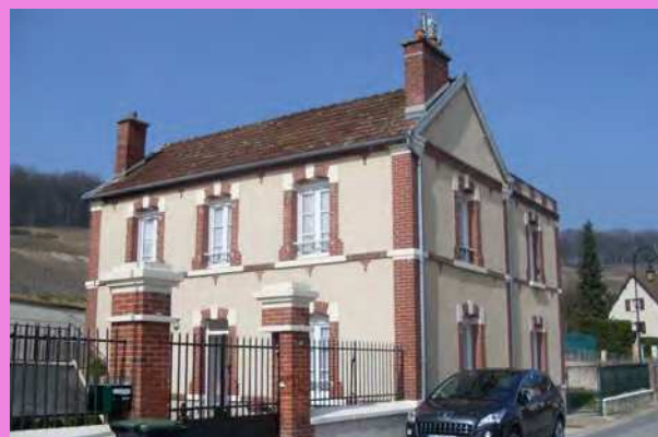
Volume souligné par des encadrements de briques, associés à de la pierre, sur un mur enduit avec un jeu de couleurs en façade
