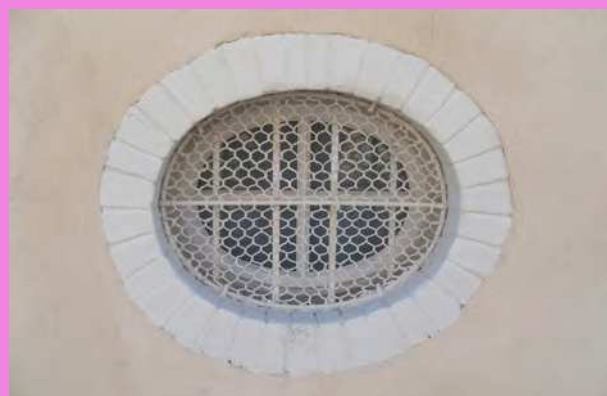
Briques, ferronneries et menuiseries de teinte blanche très claire, en harmonie avec l'enduit beige
