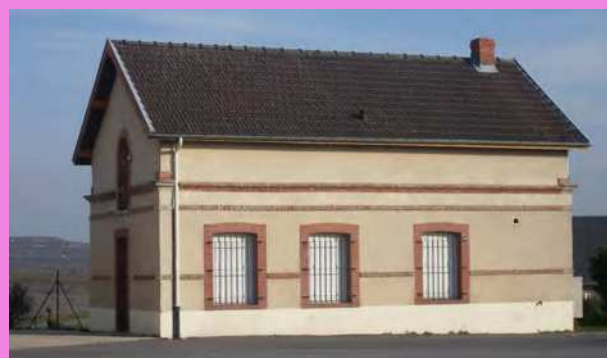
Association des enduits naturels clairs et de la brique en terre cuite (corniche, bandeau, encadrements de baies, cheminée)
