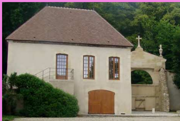
Edifice de l'Abbaye de Saint-Pierre de Hautvillers
