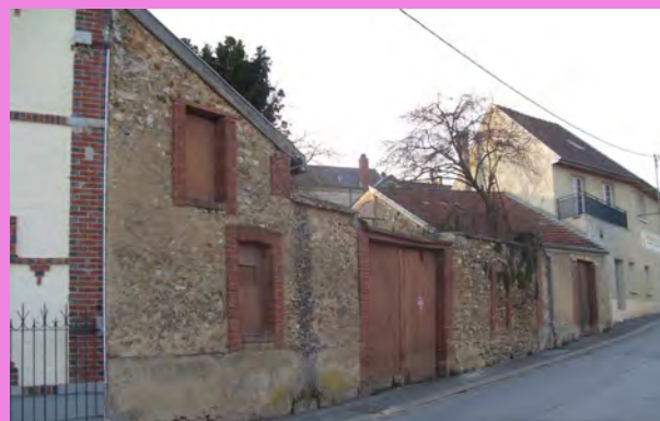
Murs de clôture en pierre en continuité des murs du bâti, composé d'un portail en bois, donnant accès sur la cour intérieure
