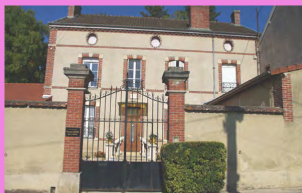
Murs de clôture en maçonnerie, couronnés de tuiles avec un portail en fer forgé, maintenu par deux piliers plus élevés en brique : L'ensemble constitue un élément architectural fort.
