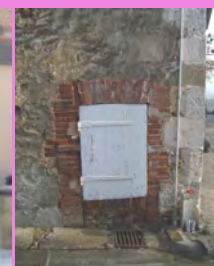
Coffrets, protégés par un volet bois peint, et inclus dans les murs anciens
