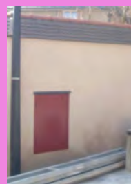
Coffrets, protégés par un volet bois peint, et inclus dans les murs anciens
