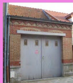
Façade ornementée, préservée lors du changement de vocation du bâti en garage
